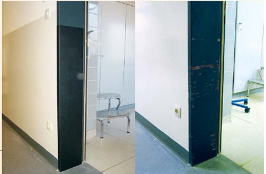
Bis zu einer Höhe von 1,22 m sind die Wände und die Türen mit Schutzfolie überzogen. Seitdem gibt es nicht mehr die typischen ‚Bettenschiebe-Kratzer‘ wie früher. BILDER: THILO THIEME
